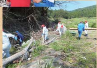
瓦礫撤去の様子
