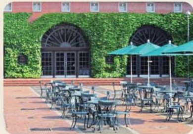
▲倉敷アイビースクエア。明治時代の倉敷紡績所(現クラボウ)発祥工場を可能な限り保存・再利用した、ホテルも兼ね備えた複合観光施設。
