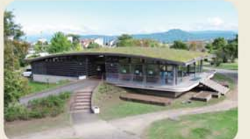
▶ 広木地区にある 管理棟。公園を見 ながら休憩でき るスペースもあり ます。
