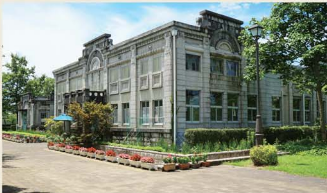
▲旧中島浄水場ポンプ室棟。
