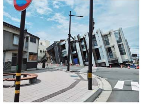
▲倒壊した7階建てビル(輪島市河合町)。隣りの店舗が下敷きになり犠牲者が出た。
